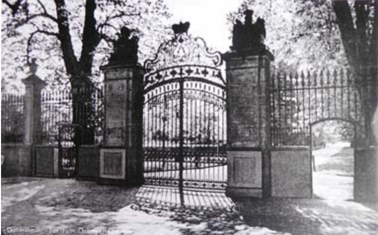
Früher. Das Portal stammt vom ehemaligen Marktpalais.
