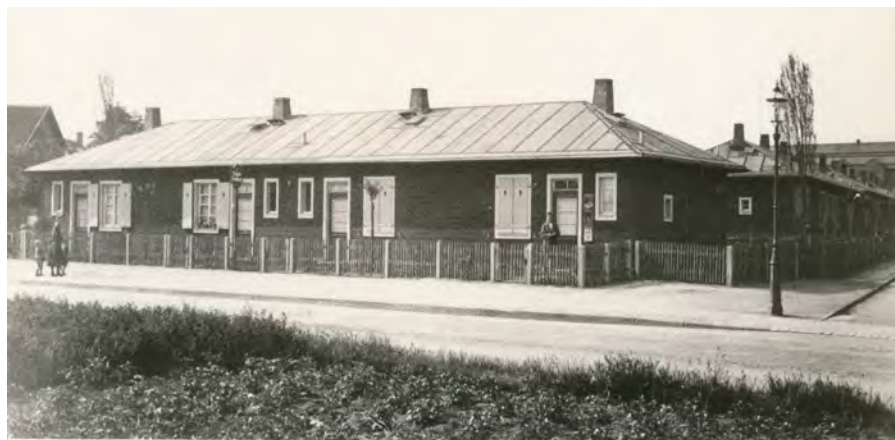
Die Grohbergkolonie wurde 1930 um 16 Wohnungen von Architekt Hoffmann erweitert. Qu.: Buxbaum-Tabellen
