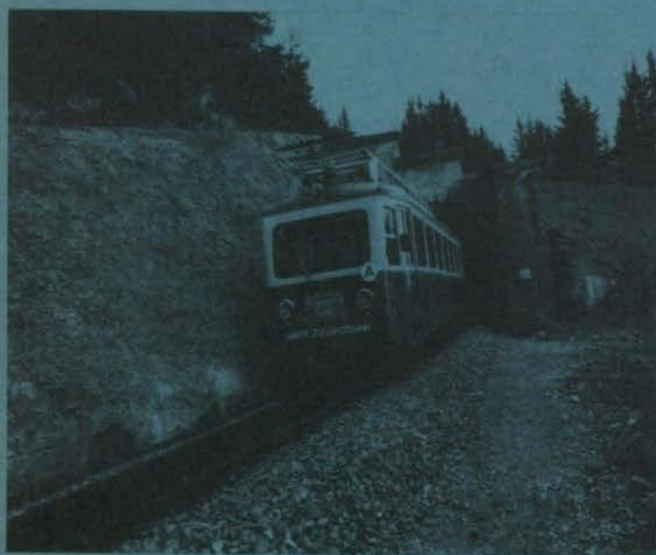
Stützmauer-Sanierung der Bayer. Zugspitzbahn beim „Kleinen Tunnel“ oberhalb des Alpsees durch Erdvernagelung.
