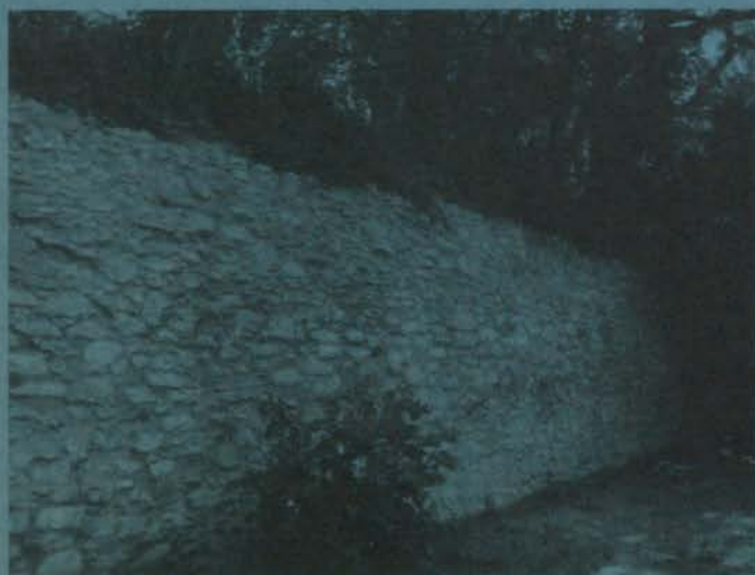
Stützmauersanierung Rüsselsheim unter Berücksichtigung der Ökologie.
