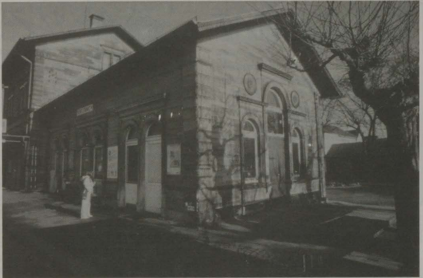
Der Bahnhof Egelsbach in seinem heutigen Zustand.
