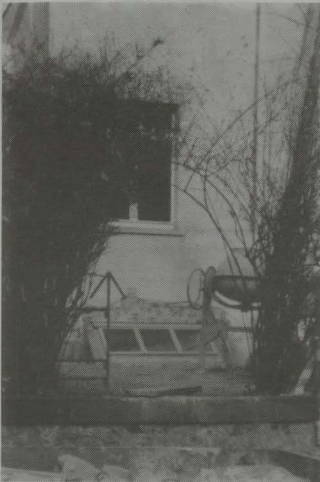
Mathildenhöhweg 2: schräges Glasfenster am Kellergeschoß. (Schardt 2. 12. 82)
