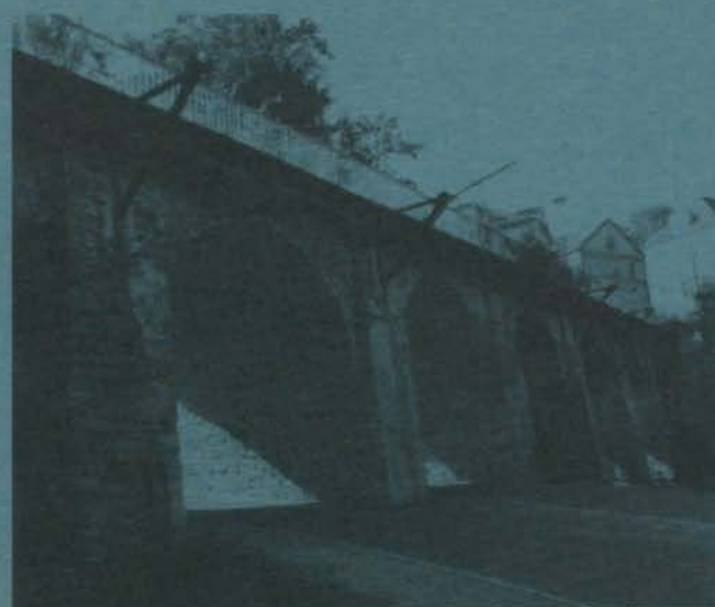
Sanierung Schlüsselbrücke Annaberg.
