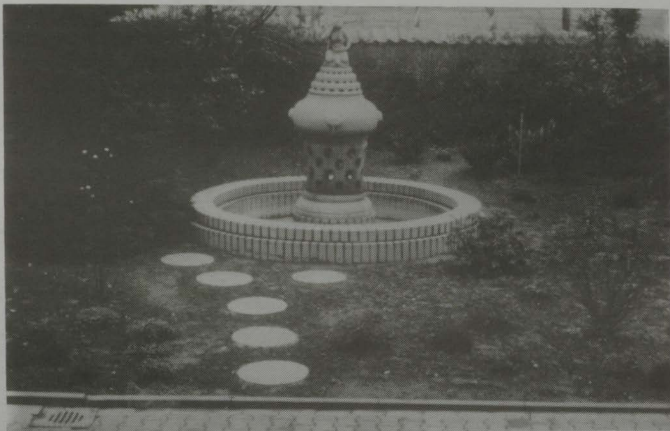
Brunnen auf dem Gelände der Südhessischen Gas und Wasser AG nach 1975. Rand und Trittsteine aus in der Farbe passenden Fliesensteinen. (20.12.84 Wi)
