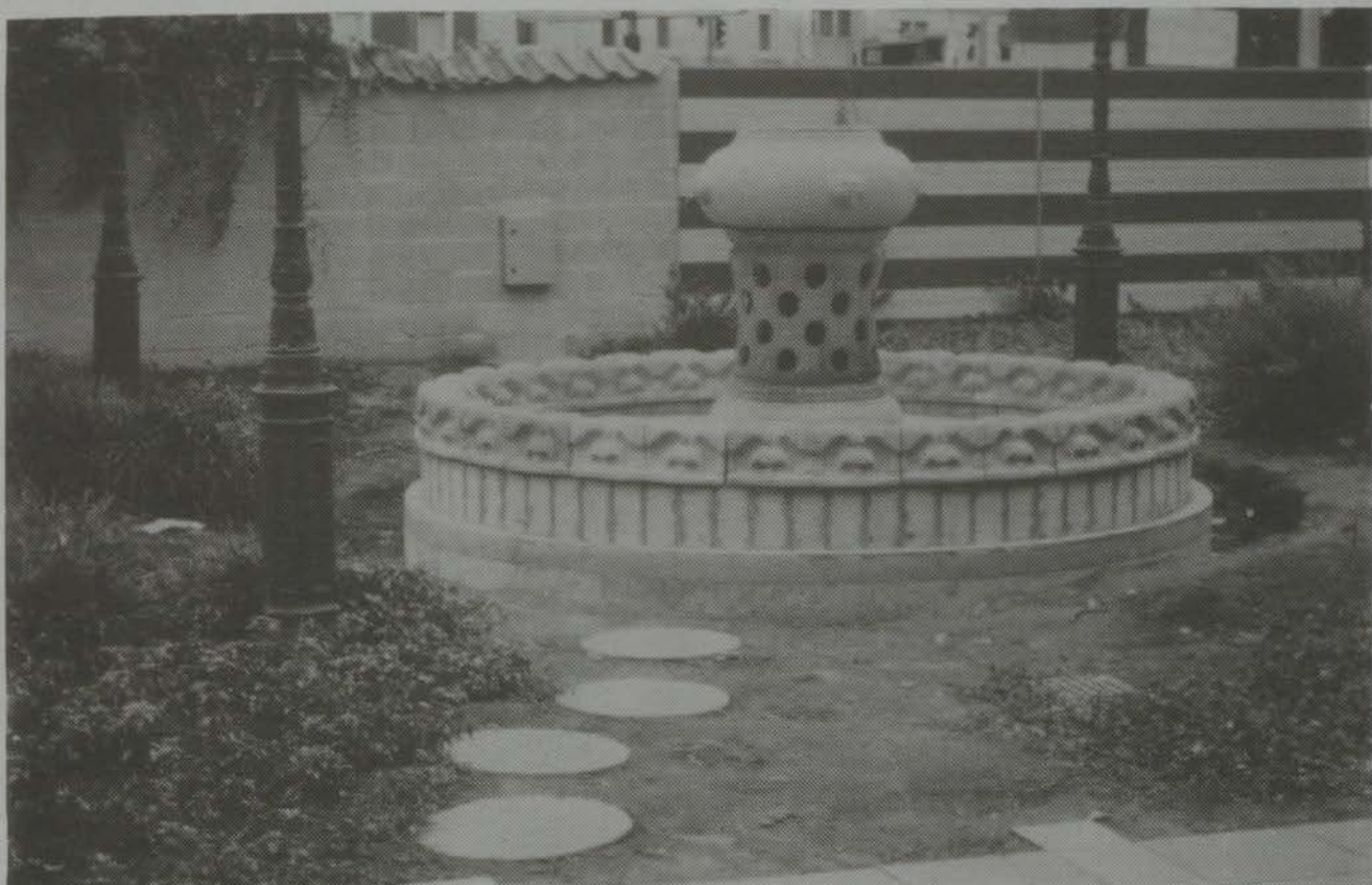
Neuaufbau mit nachgegossenem (Original-)Brunnenrand.
