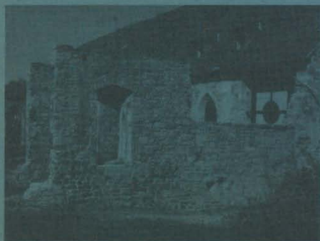
Sanierung der Klostermauer Hornbach
