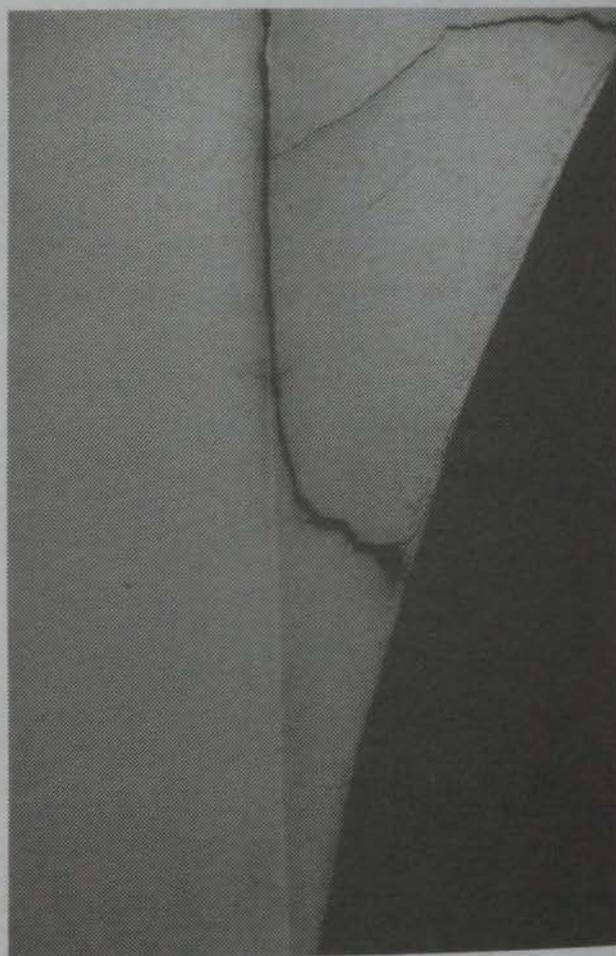
Ausgeprägte, tiefe Risse (z. T. breiter als 10 mm) an den Verbindungsstellen zwischen Giebelwand und Turm.
