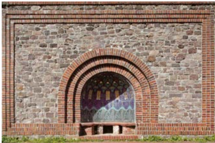
Albinmüller: Mosaiknische an der Ostseite des Ausstellungsgebäude auf der Mathildenhöhe
