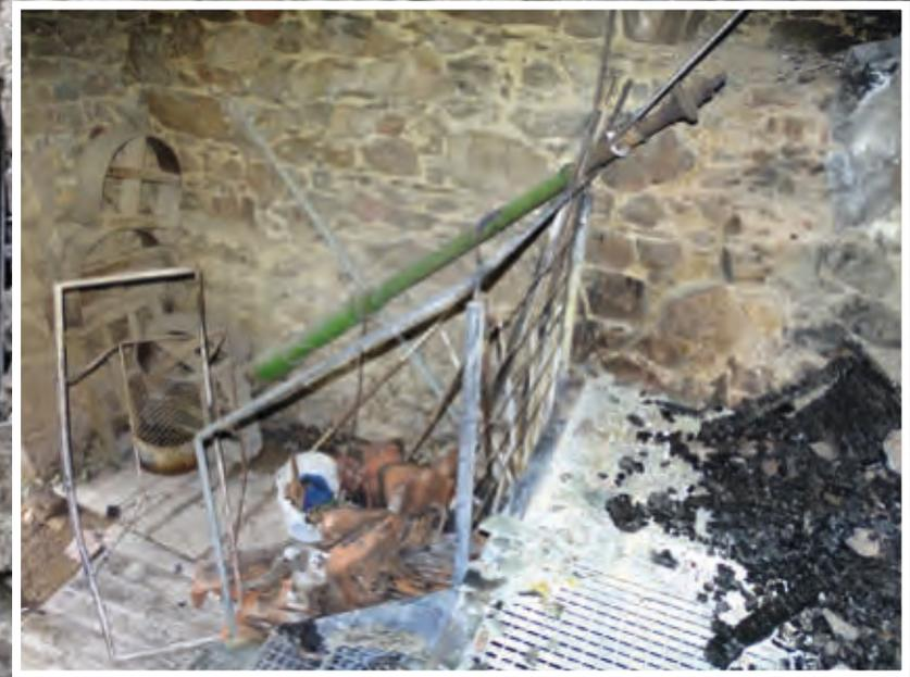
**SPUREN EINES BRANDES.** Das Feuer im Hinkelsturm hat vor allem Schäden an der Elektro-Installation angerichtet und den Sicherungskasten zerstört.
