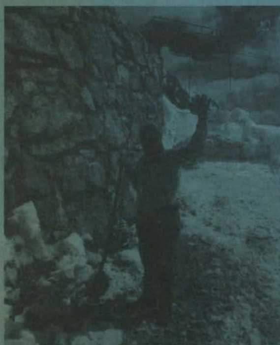
Stützmauer-Sanierung auf der Zugspitze.
