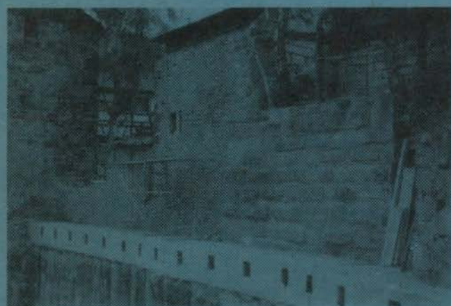
Stadtmauer Sicherung-Sanierung Roth/Nürnberg
