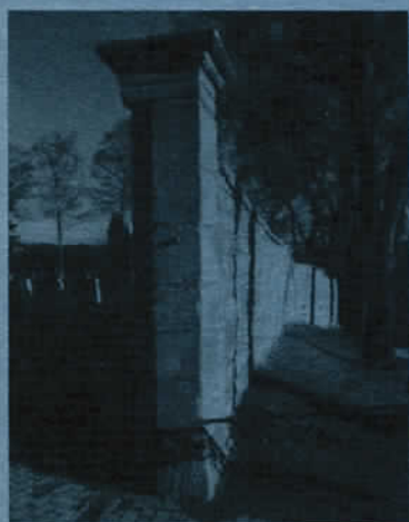
Sanierung der Friedhofsmauer der Ev. Kirche Bodelshausen (Aust. 1994).
