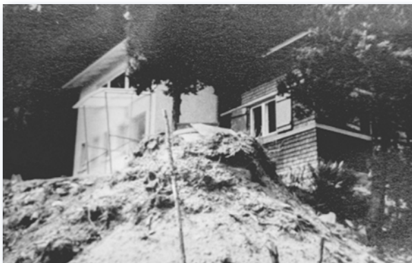
Mid-century-Bausünden: Das Haus im Umbau.
